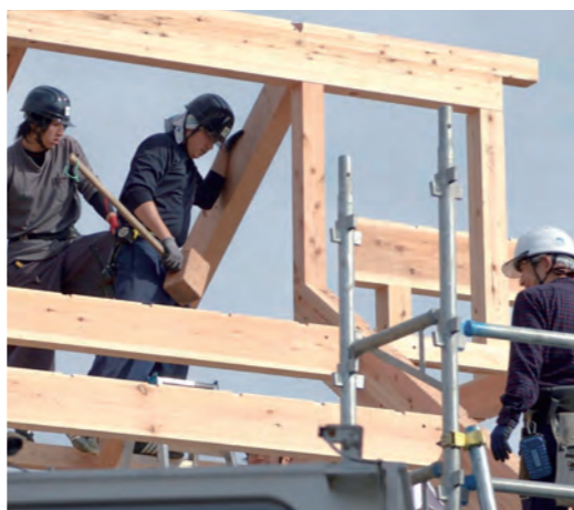
躯体工事を自分たちでできるのも強み。
