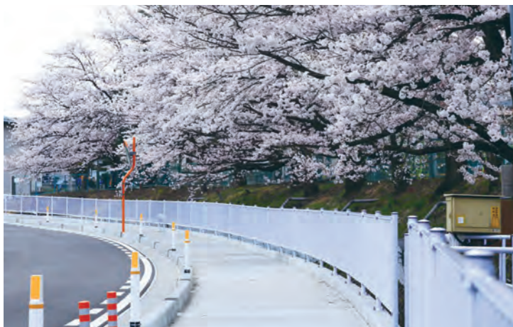
中山町豊田地区歩道設置工事(平成26年3月完成)
